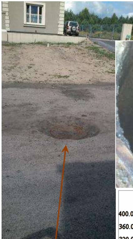
Studnia pomiarowa z niewidocznym zestawem „GACEK”. Zestaw „GACEK” jest zasilany z baterii.
