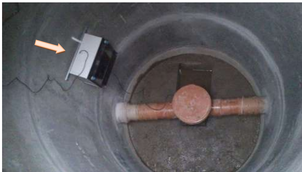
Przykład zrealizowanej instalacji zestawu pomiarowego z zasilaniem akumulatorowym (tu: z częścią czujnikową GROM K). Szafka pomiarowa została zainstalowana na ścianie studni.
