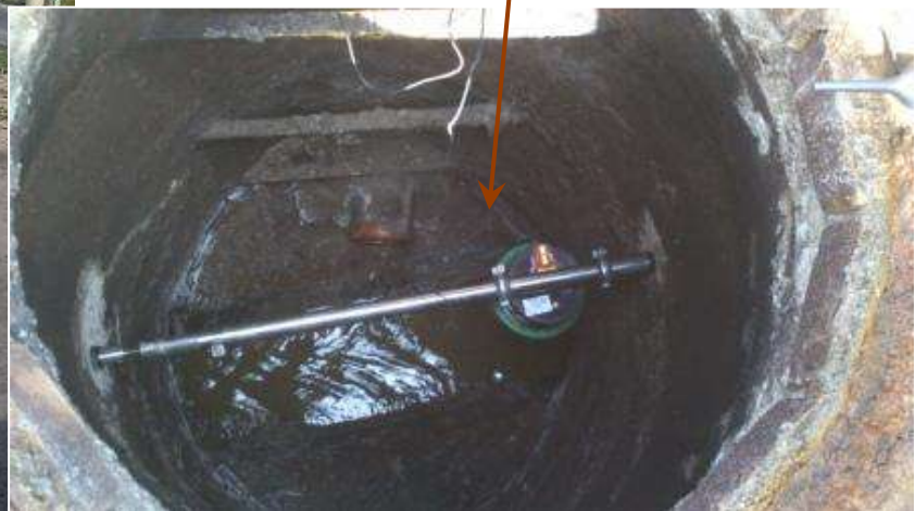
„GACEK” w wersji kompaktowej, zainstalowany w studni
