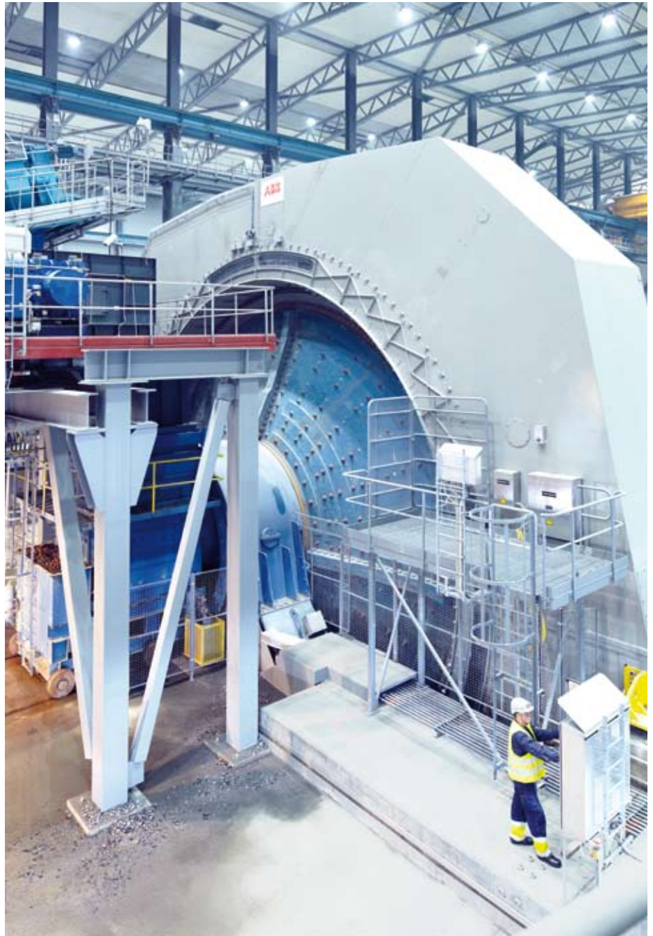
Bezprzekładniowe napędy do młyna to serce procesu produkcyjnego kopalni. Na zdjęciu jeden z dwóch 22,5-megawatowych systemów napędowych ABB zainstalowanych na ponad 12-metrowym młynie w szwedzkiej kopalni miedzi Aitik firmy Boliden. (Fot. Arch. ABB)
