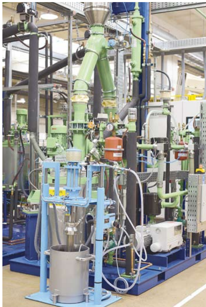
Linia produkcyjna przekładników napowietrznych w Przasnyszu. (Fot. Adam Stephan/Arch. ABB)
