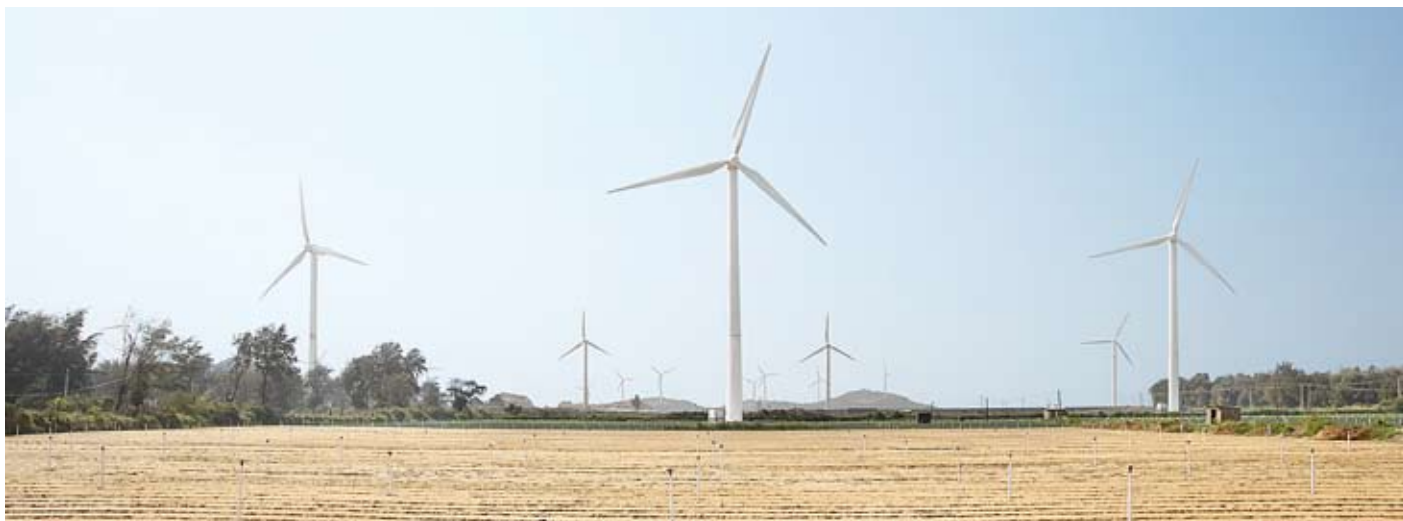
Synchronizacja czasu przy użyciu protokołu SNTP pozwala sterować oświetleniem wysokościowym masztów elektrowni wiatrowych. (Fot. Arch. ABB)
