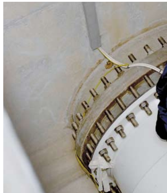
Zygfryd Głuchy prezentuje jeden z największych na rynku ściekomierzy, zainstalowany przez ALFINE-TIM w poznańskiej Lewobrzeżnej Oczyszczalni Ścieków.
