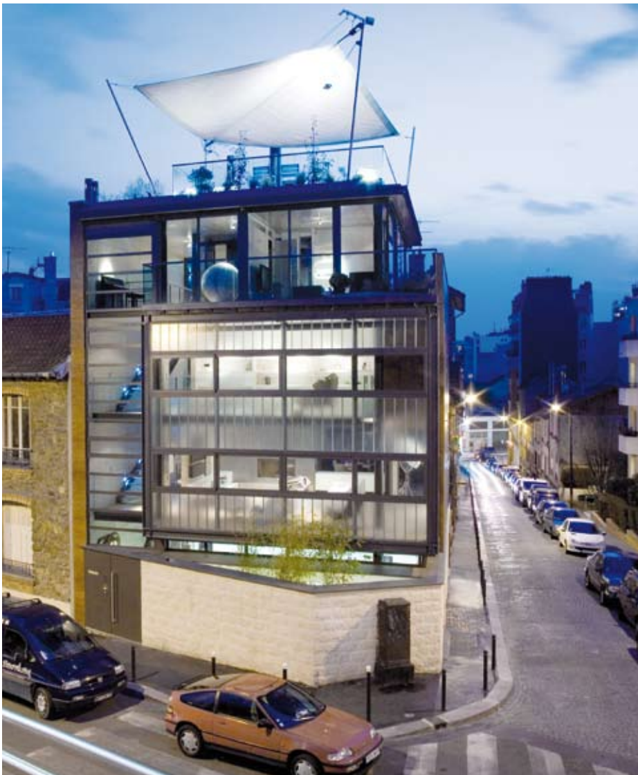
Dom mieszkalny w Ratingen zbudowany z wykorzystaniem technologii KNX do połączenia i scentralizowania poszczególnych części systemu zarządzania budynkiem. (Fot. Arch. ABB)
