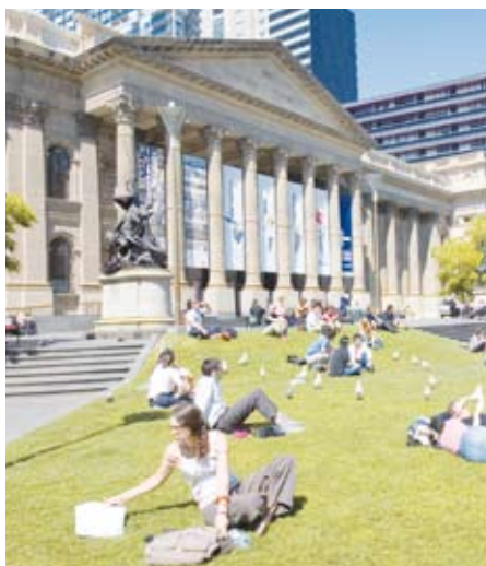
Biblioteka Stanowa w Melbourne. (Fot. Wikimedia Commons)
