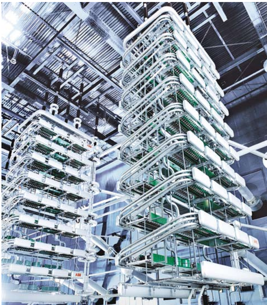
Hala zaworów HVDC na stacji elektroenergetycznej w Latina. (Fot. Arch. ABB)
